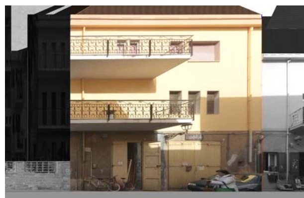
Profilo stato attuale (fotoraddrizzamento)
