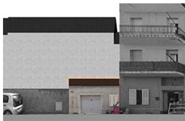
Profilo stato attuale (fotoraddrizzamento)
