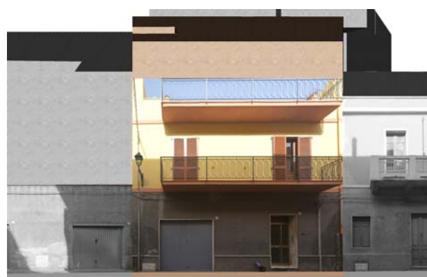
Profilo stato attuale (fotoraddrizzamento)
