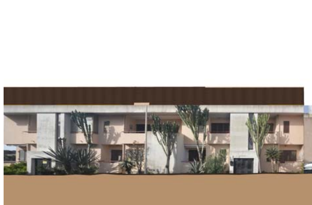
Profilo stato attuale (fotoraddrizzamento)
