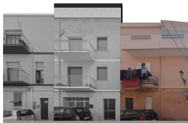
Profilo stato attuale (fotoraddrizzamento)
