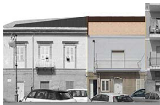
Profilo stato attuale (fotoraddrizzamento)
