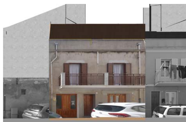
Profilo stato attuale (fotoraddrizzamento)
