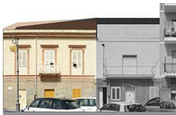
Profilo stato attuale (fotoraddrizzamento)
