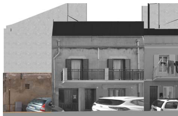
Profilo stato attuale (fotoraddrizzamento)
