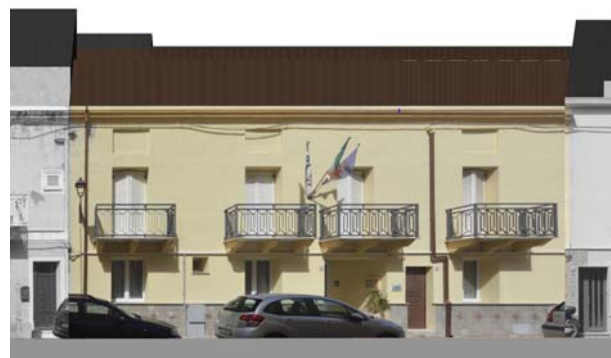
Profilo stato attuale (fotoraddrizzamento)
