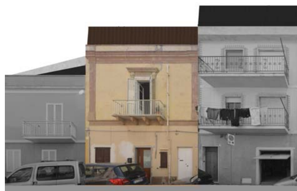
Profilo stato attuale (fotoraddrizzamento)
