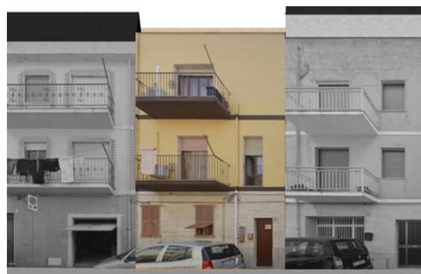
Profilo stato attuale (fotoraddrizzamento)
