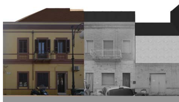
Profilo stato attuale (fotoraddrizzamento)
