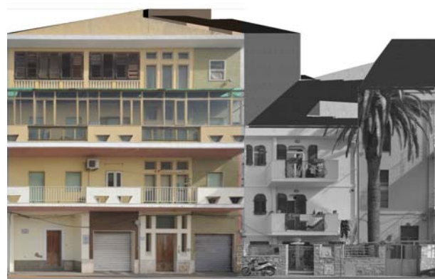
Profilo stato attuale (fotoraddrizzamento)
