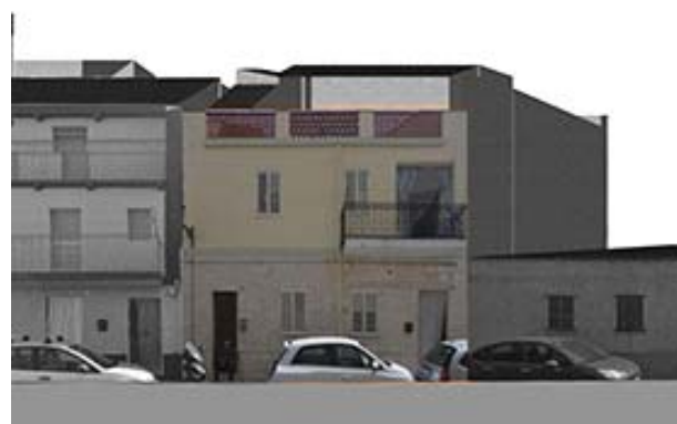
Profilo stato attuale (fotoraddrizzamento)
