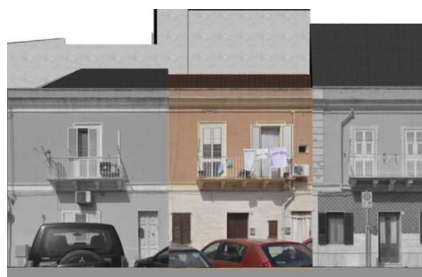
Profilo stato attuale (fotoraddrizzamento)
