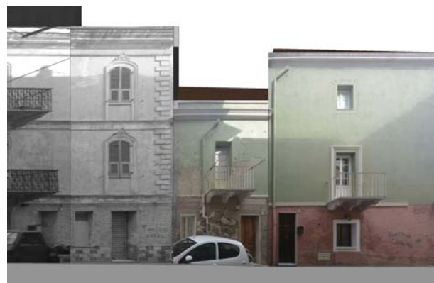
Profilo stato attuale (fotoraddrizzamento)
