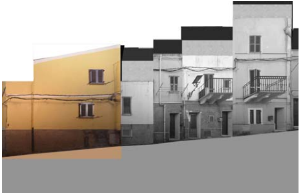
Profilo stato attuale (fotoraddrizzamento)
