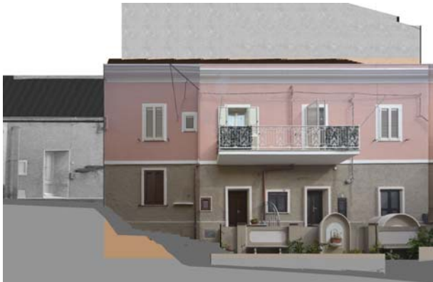
Profilo stato attuale (fotoraddrizzamento)
