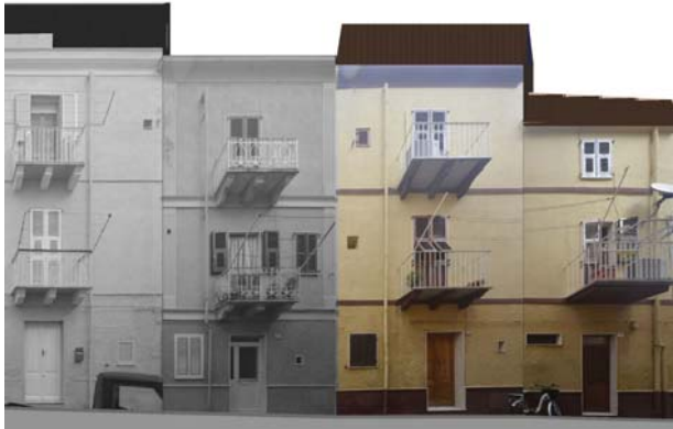
Profilo stato attuale (fotoraddrizzamento)
