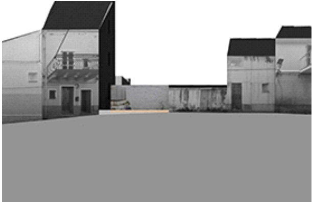
Profilo stato attuale (fotoraddrizzamento)
