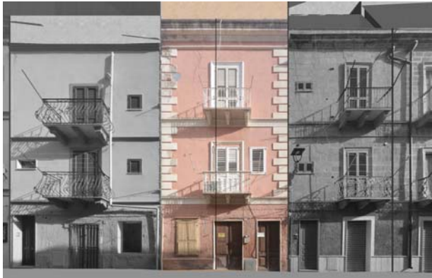
Profilo stato attuale (fotoraddrizzamento)
