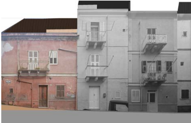
Profilo stato attuale (fotoraddrizzamento)
