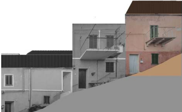
Profilo stato attuale (fotoraddrizzamento)
