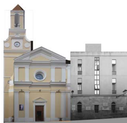
Profilo stato attuale (fotoraddrizzamento)
