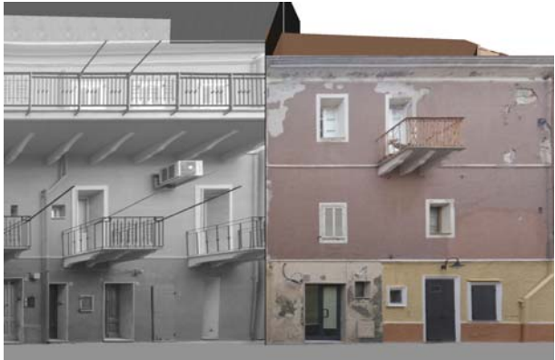
Profilo stato attuale (fotoraddrizzamento)
