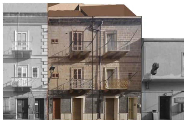
Profilo stato attuale (fotoraddrizzamento)
