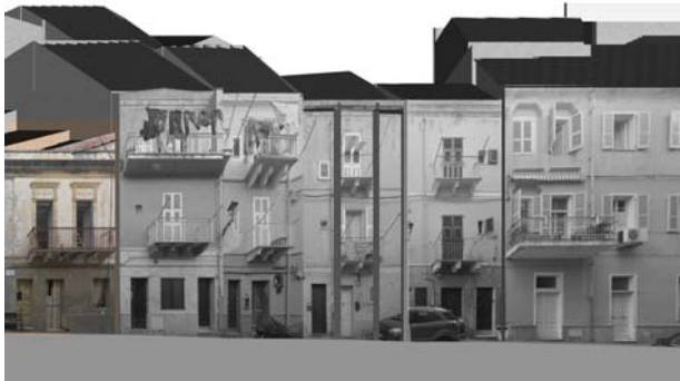
Profilo stato attuale (fotoraddrizzamento)
