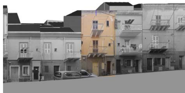
Profilo stato attuale (fotoraddrizzamento)
