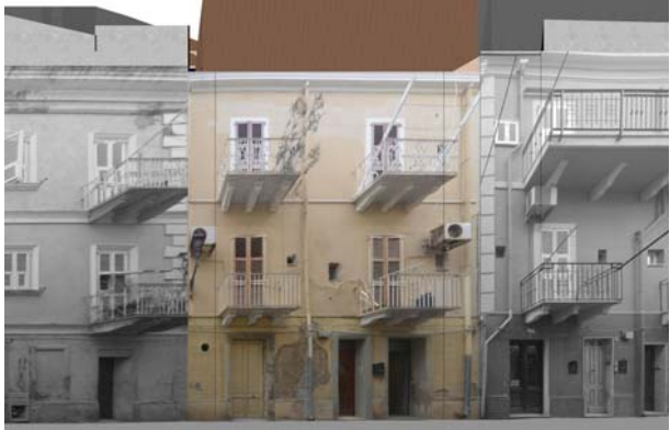
Profilo stato attuale (fotoraddrizzamento)
