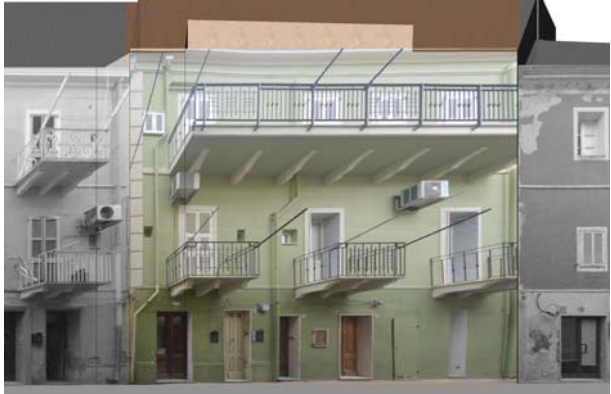
Profilo stato attuale (fotoraddrizzamento)
