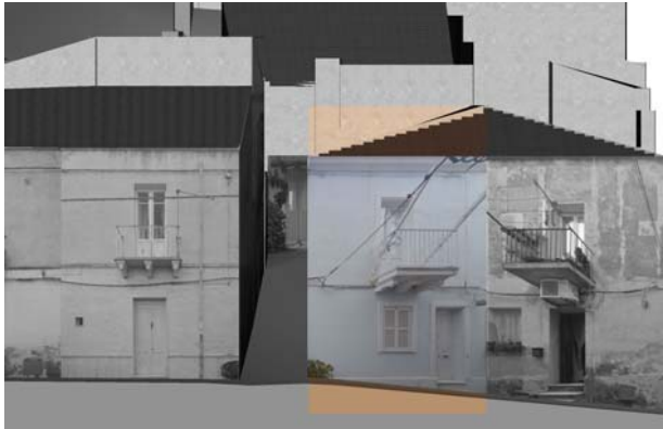
Profilo stato attuale (fotoraddrizzamento)
