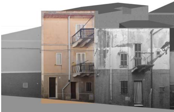
Profilo stato attuale (fotoraddrizzamento)
