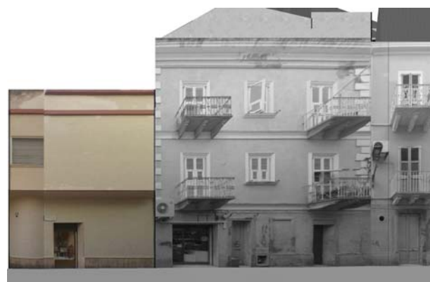
Profilo stato attuale (fotoraddrizzamento)
