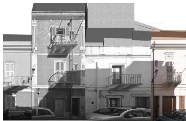
Profilo stato attuale (fotoraddrizzamento)
